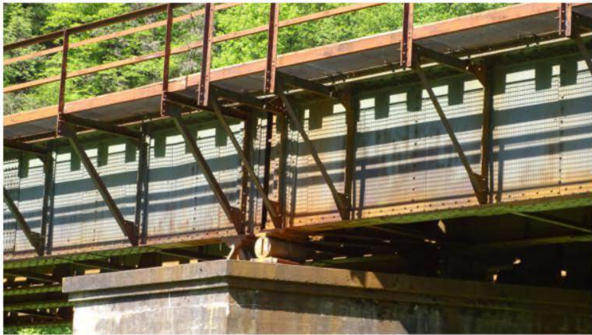
Eisenbahnbrücke über die Sieg
