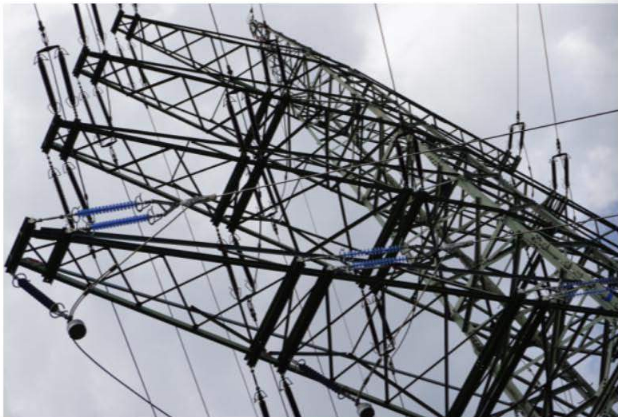
Strommast auf dem Bühl
